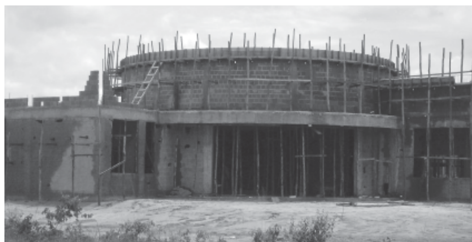
Fachada do prédio do laboratório
